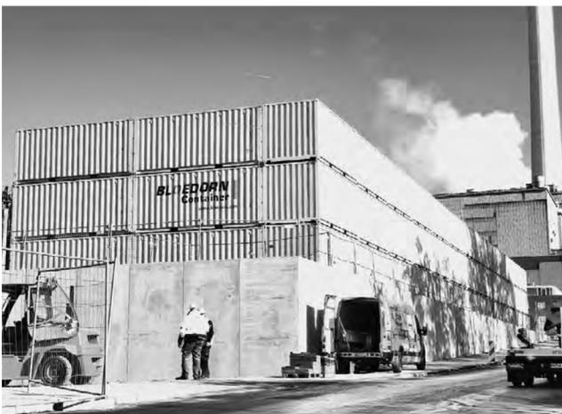
Die Lärmschutzwand wurde mit Stapler und Kran aufgebaut.
