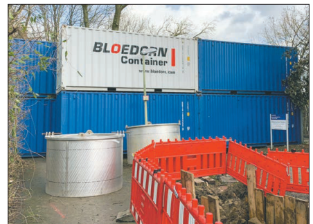
Containerschutzwände helfen auch bei der Kampfmittelräumung. Foto: BS/Bloedorn
