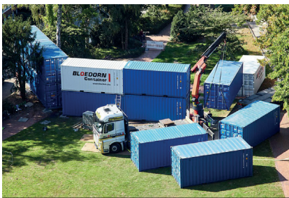
Aufbau einer Seecontainerwand nach einem Bombenfund in Münster (Werkfoto)
