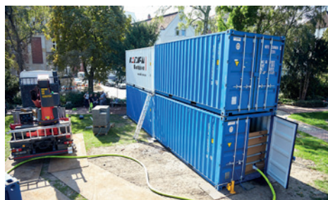
Eine zweilagige Containerwand in NRW im Einsatz.
