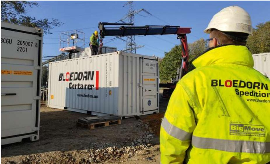
Aufbau mit Stapler und Kran: Die Lärmschutzwand aus Seecontainern wird je nach Baufortschritt versetzt. | Foto: Bloedorn Container
