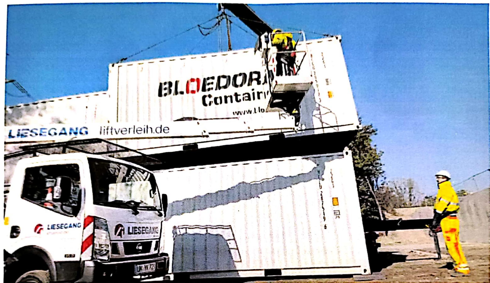
Mit einem Kran wurden die Seecontainer abgeladen, die in Herne als Lärmschutzwand für einen Kraftwerksbau dienen.
